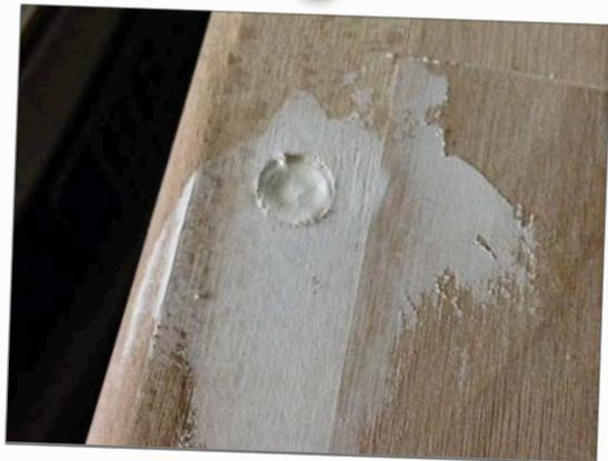
Die Löcher wurden mit Molto Holzkitt gefüllt und anschließend geschliffen.
